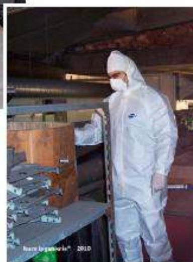
En la imagen se presenta una etapa de diagnóstico, identificación y comprobación visual del buen estado de conservación de MCA (materiales con amianto).
