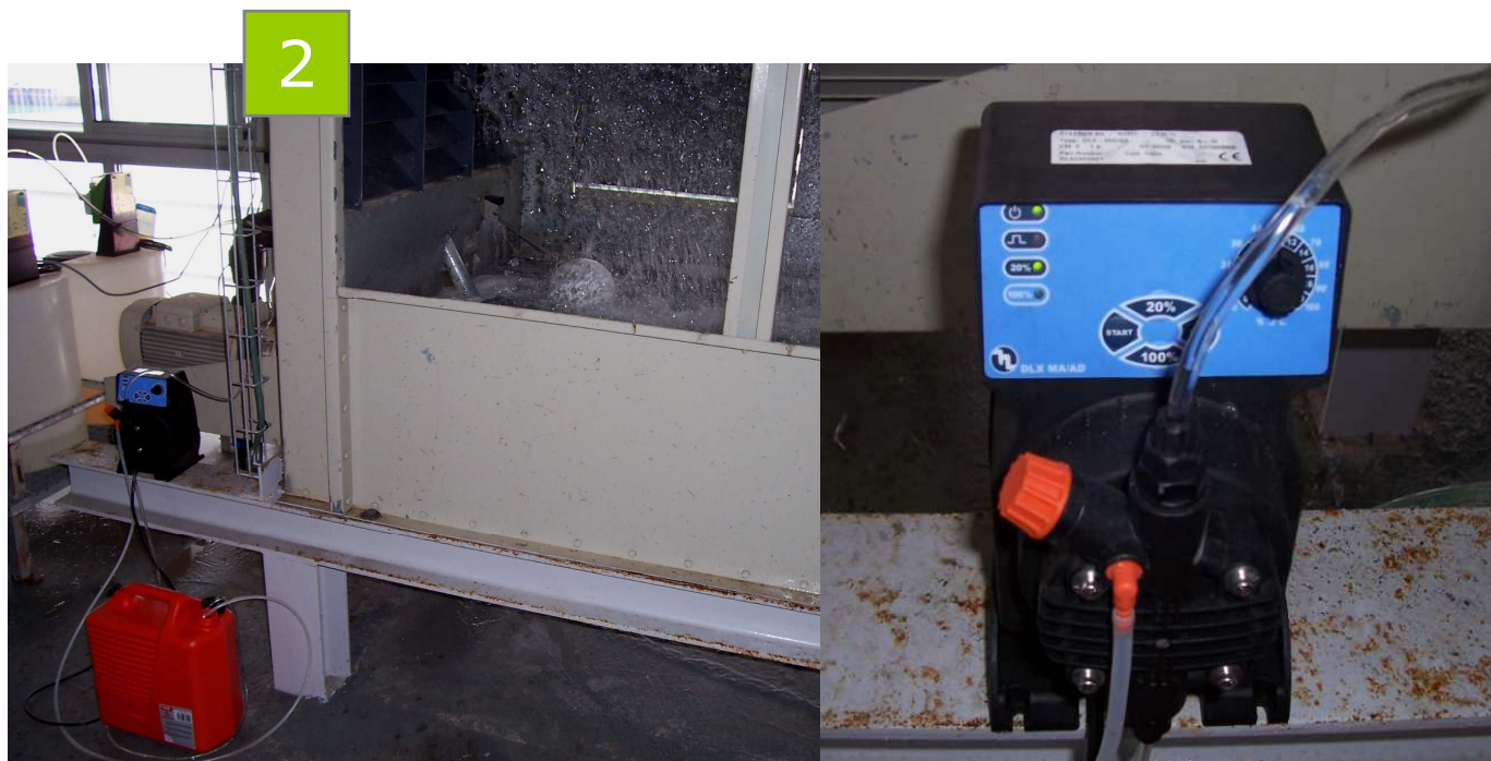
2 Dosificación del biocida (hipoclorito sódico) con bomba automática a un valor de 5 ppm de cloro residual libre en balsa. Junto con el biocida se añade un biodispersante compatible con el cloro.
